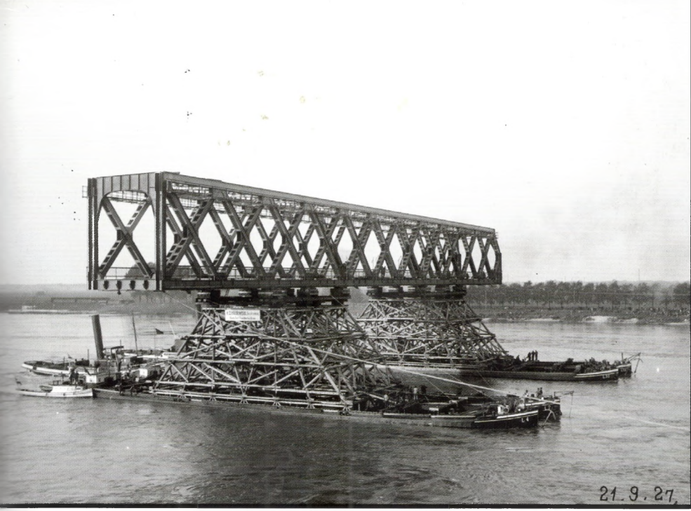
Montage der Eisenbahnbrücke über den Rhein bei Wesel, 1927
