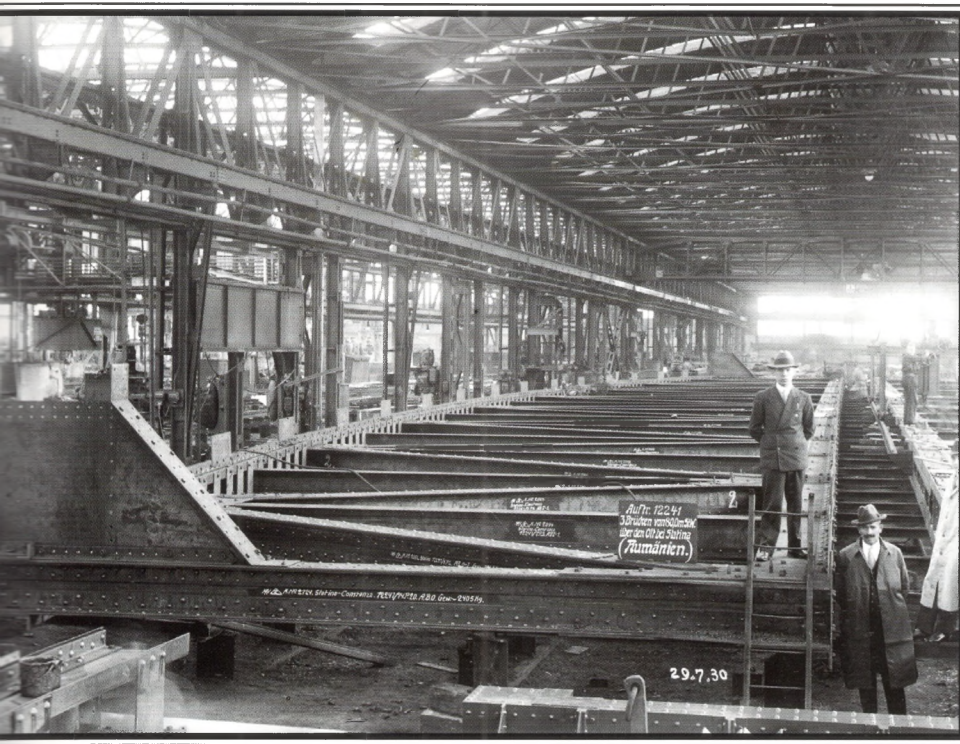
In der Brückenbauwerkstatt: Träger für ein Brückenprojekt über den Fluss Olt bei Slatina in Rumänien, 1930
